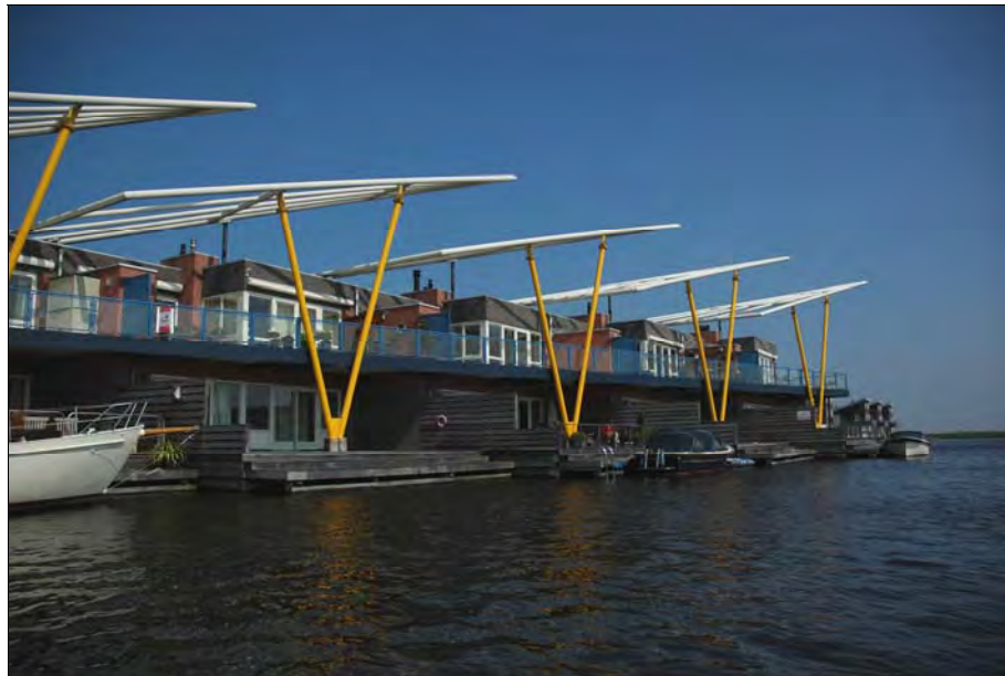
Kleur- en materiaalgebruik: Deze invulling bij de entree van het dorp is opvallend en uitbundig in zijn verschijning. De overdaad van buizen in een lichte kleur maakt dat de bebouwing zich minder goed voegt in het landschap. Meer terughoudende kleuren zouden hier beter passen.
